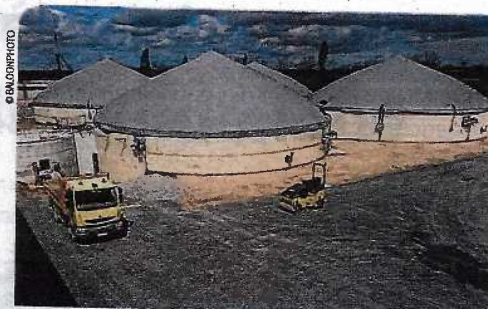
« Sur 1 000 t de fumier incorporées dans les cuves, on récupérera 1 000 t de digestat. »
