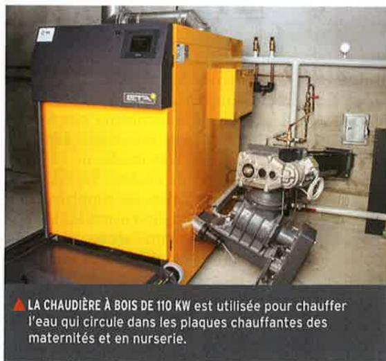
▲ LA CHAUDIÈRE À BOIS DE 110 KW est utilisée pour chauffer l'eau qui circule dans les plaques chauffantes des maternités et en nurserie.
