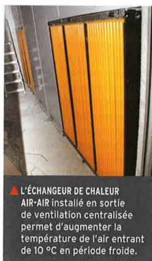
▲ L'ÉCHANGEUR DE CHALEUR AIR-AIR installé en sortie de ventilation centralisée permet d'augmenter la température de l'air entrant de 10 °C en période froide.
