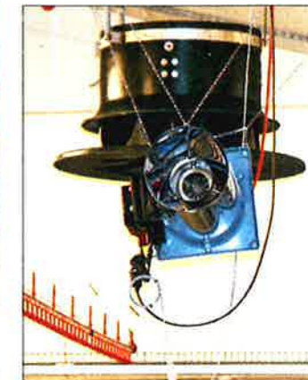
▲ Un système de chauffage au gaz placé au plafond permet d'assurer une température constante à 20 °C tout au long de l'année.
