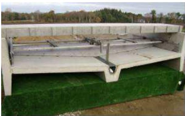
Photographie 1 : la forme du raclage est adaptée au fond de fosse en V. La gouttière centrale collecte les urines.
