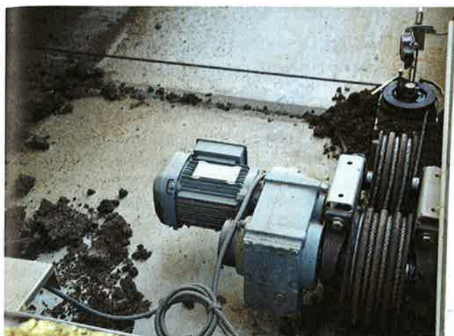
Le moteur permet de tirer le racleur.
