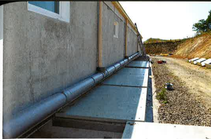
Les racleurs passent sous les caillebotis toutes les quatre heures.
