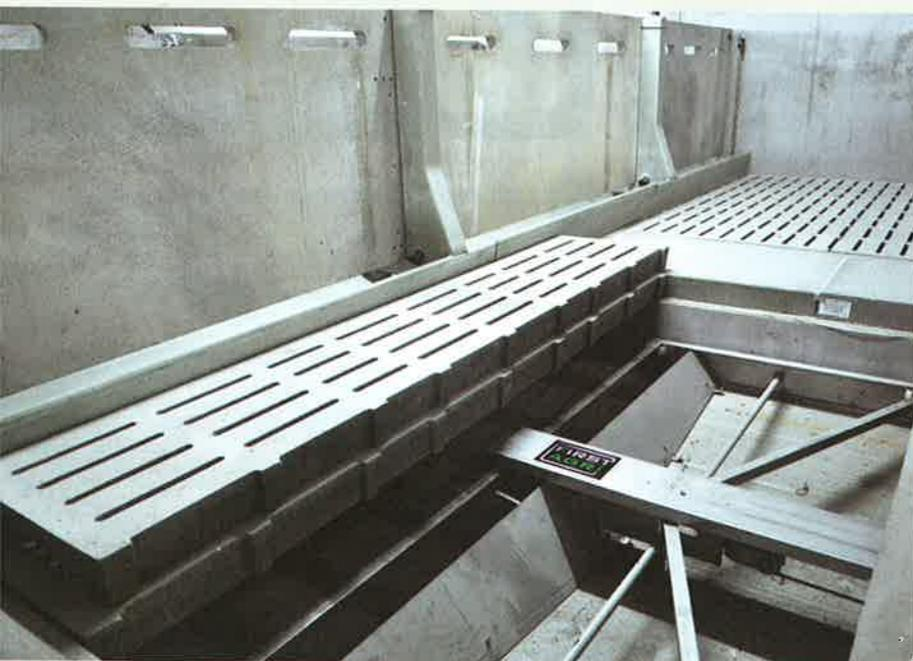
**Raclage en V.** Dans chaque salle trois gaines d'extraction sont intégrées: une dans le couloir central (30 % de la ventilation), et une dans chacune des rangées de case (pour 30 % de ventilation chacune). Les modules de raclage sont conçus avec des réservations pour le passage de l'air vicié dans le couloir central de la salle.
