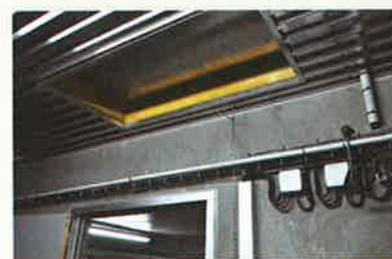
➤ **La trappe manuelle de sélectivité** disposée dans le couloir permet de choisir l'air entrant issu soit du couloir, soit du comble. A gauche, la trappe est fermée obligeant l'air préchauffé du couloir à aller dans la salle. A droite, c'est l'inverse: les trappes sont ouvertes pour obliger l'air extérieur à aller dans la salle. Dans chacune, l'air arrive par une gaine isolée située dans le comble.
