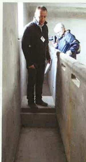
▲ **Le garage du raclage en V** se situe à l'intérieur du bâtiment pour faciliter l'entretien, limiter l'usure, éviter l'aménagement de coffres extérieurs. La contrainte: 70 cm de surface en plus sont nécessaires sur la largeur du bâtiment.
